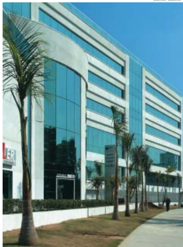
No prédio do Ibmecc, em São Paulo, isolamento acústico foi obtido com combinação do vidro refletivo e laminado fornecido pela Glassec
