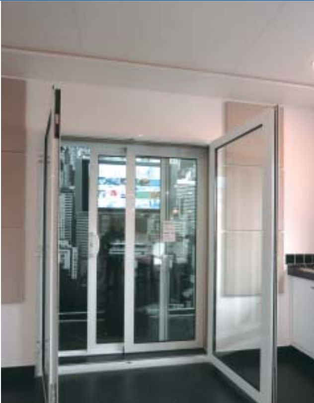
Casa Saint-Gobain: duas portas de laminados duplos instaladas no Espaço Gourmet isolaram, pelo menos, 41 dB dos 130 dB gerados
