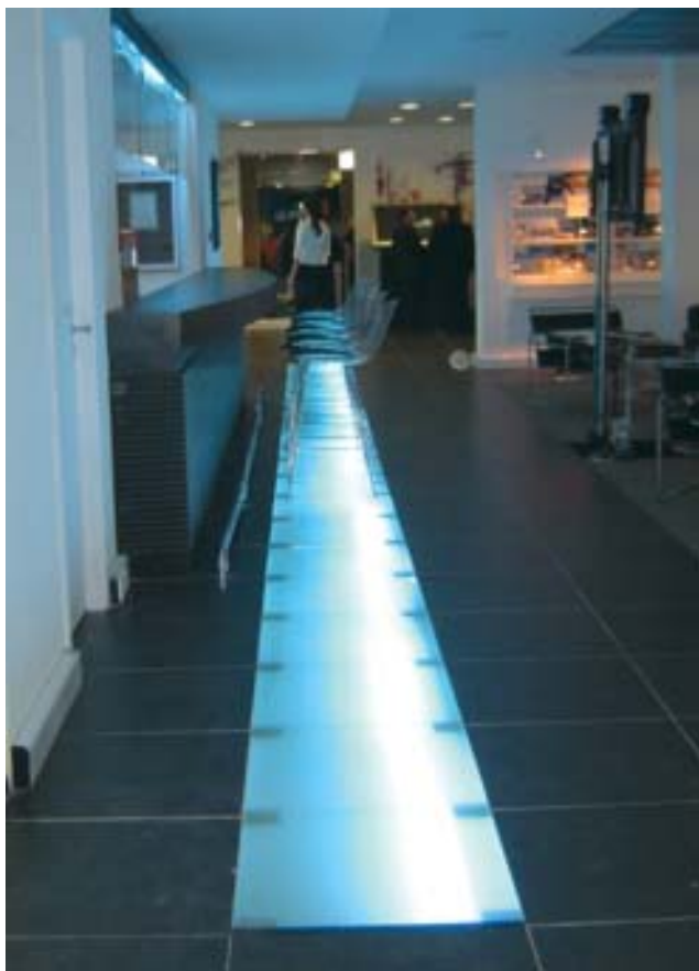
Multilaminado da Glassecc: vidro foi aplicado em piso da entrada do Pavilhão de Exposições do Anhembi, em São Paulo
