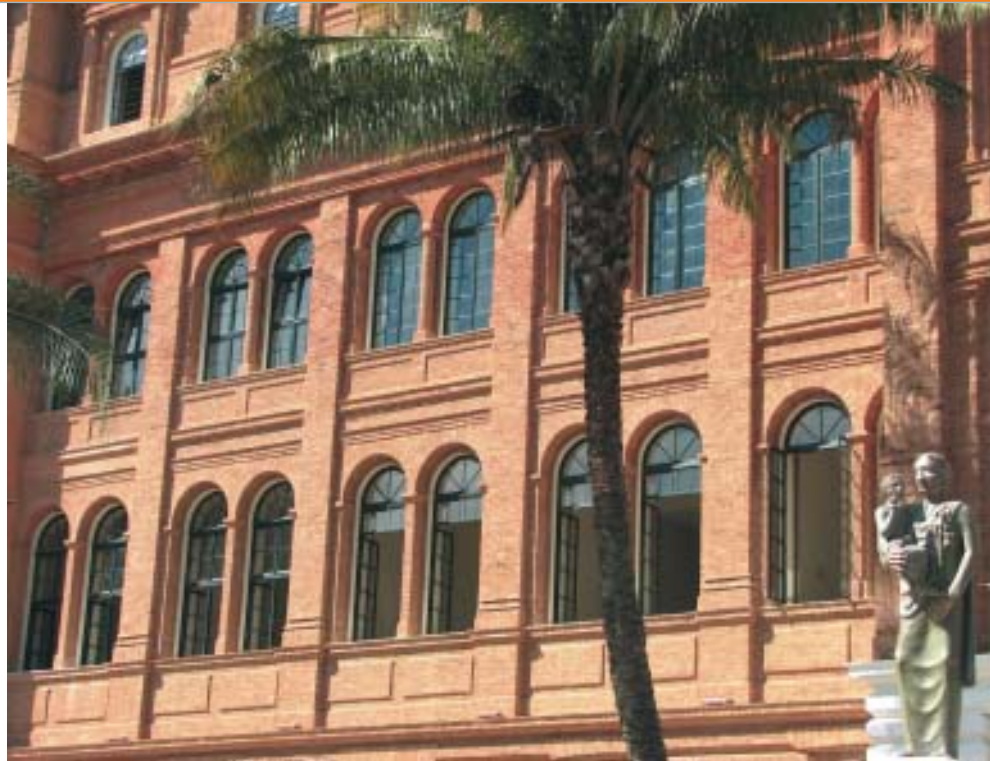
Beleza: fachada com a transparência dos produtos fornecidos pelas empresas vidreiras
