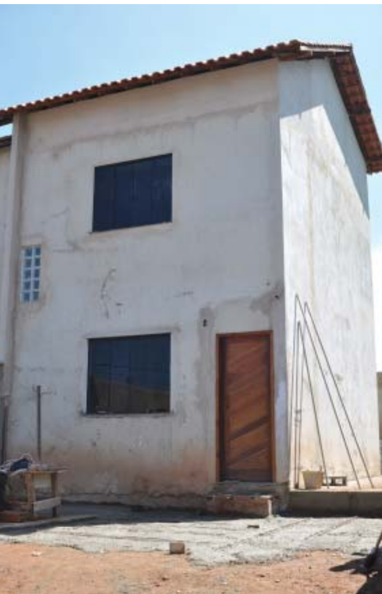
A instalação é simples e rápida: pode ser feita por um pedreiro ou pelo próprio morador
