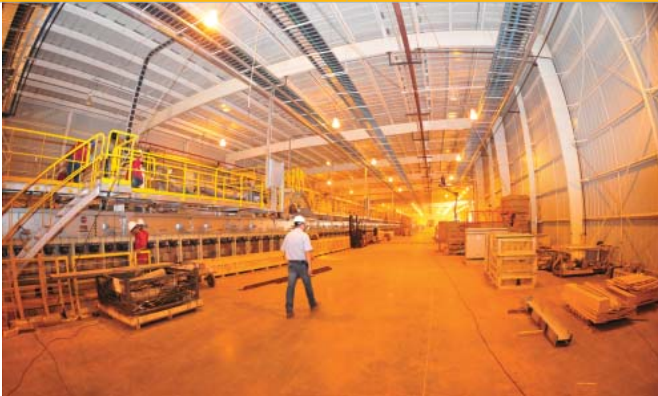
Nova fábrica foi construída em tempo recorde: cinquenta semanas de trabalho
