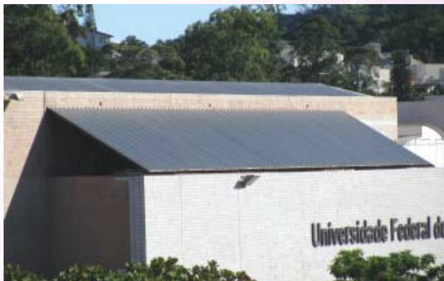
Sistema com potência de 10 kWp instalado na cobertura do Centro de Cultura e Eventos da UFSC, em operação desde julho de 2004, que gerou até hoje, em média, 1100 kWh/mês
