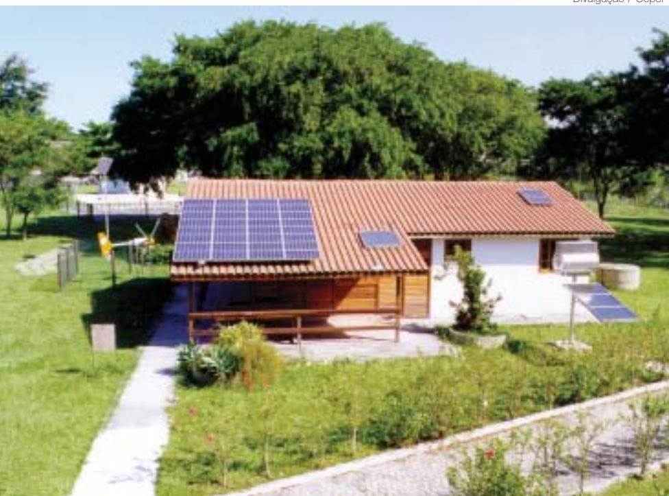
Painéis instalados na Casa Solar Eficiente, que fica na sede do Centro de Pesquisas de Energia Elétrica (Cepel), na Ilha do Fundão, no Rio de Janeiro
