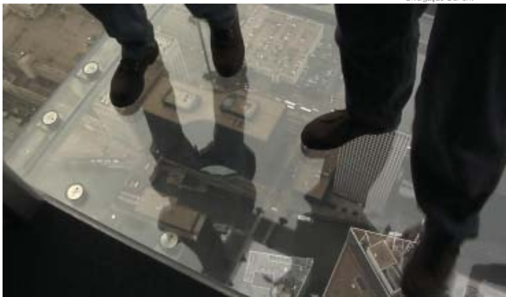
Travas de aço inoxidável unem as peças de vidro
