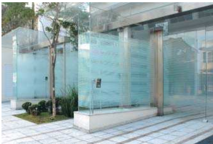
Cerca de vidro no edifício da Rua Ceará, bairro paulistano de Higienópolis
